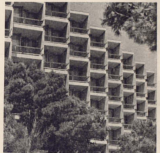
Detalle de la fachada
